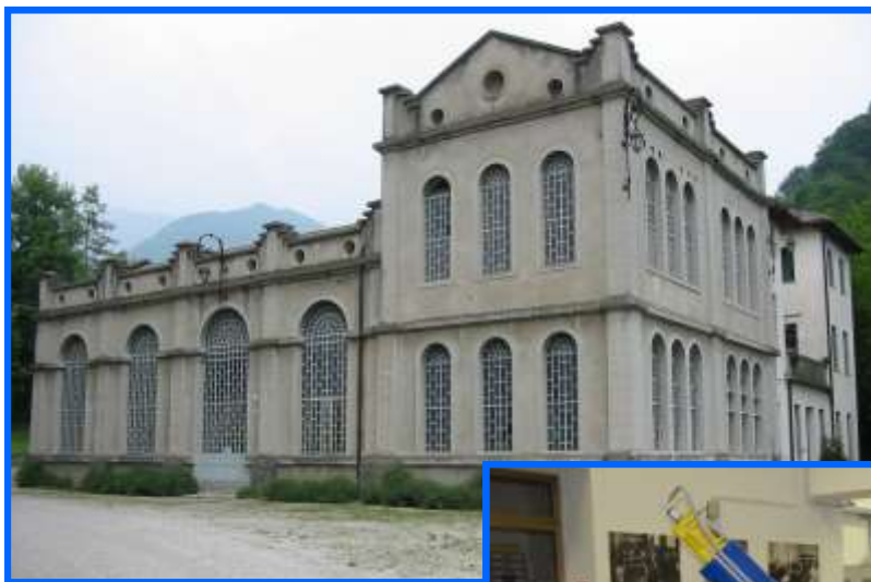
Centrale di Colmeda
