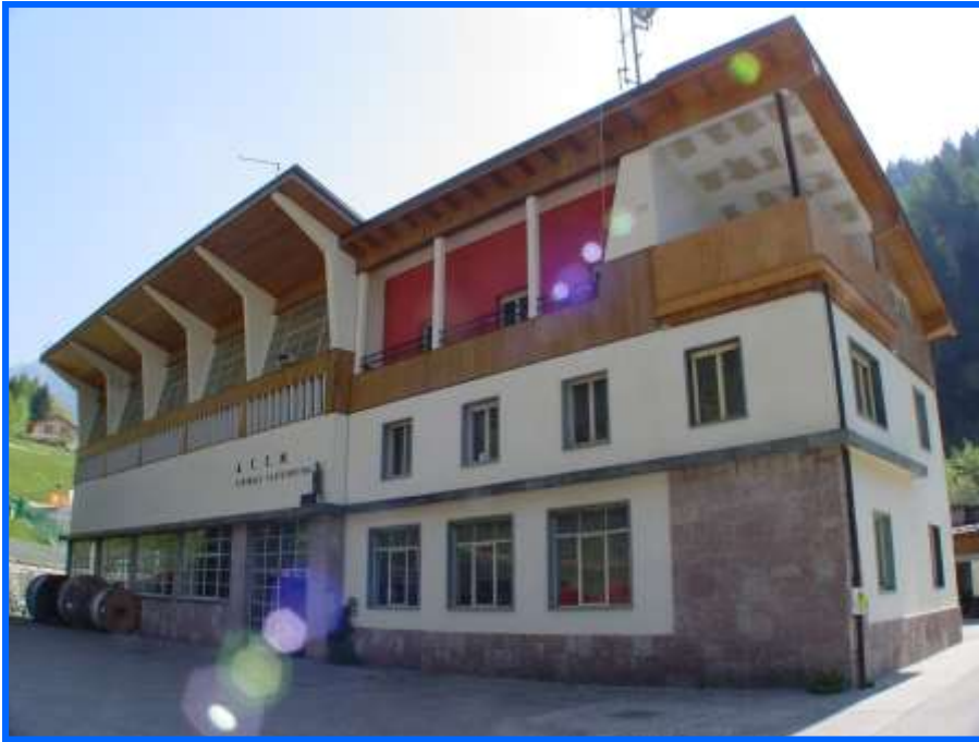
Centrale di Castelpietra
